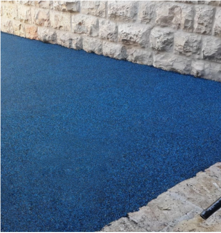
Pour in place rubber playground surface
